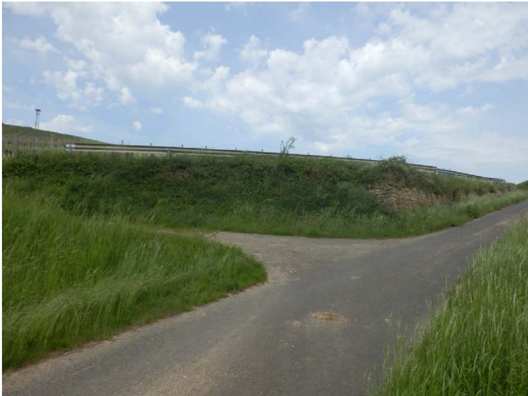
Bild 01: Biotopkomplex mit Trockenmauer und südexponierter Steilböschung von Süden, an der Oberkante Leitplanke als Absturzsicherung
